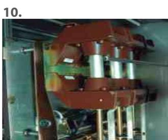
10. Os Isoladores dos seccionadores dos cubículos de linha e proteção são montados sobre uma placa metálica, unida rigidamente ao chassi para que qualquer corrente de fuga seja desviada diretamente a terra
